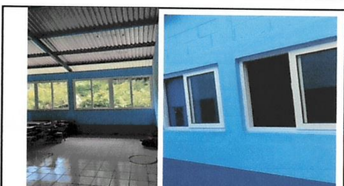
Foto 4: Pintura de exterior e interior de cocina, bodegas y aulas.
