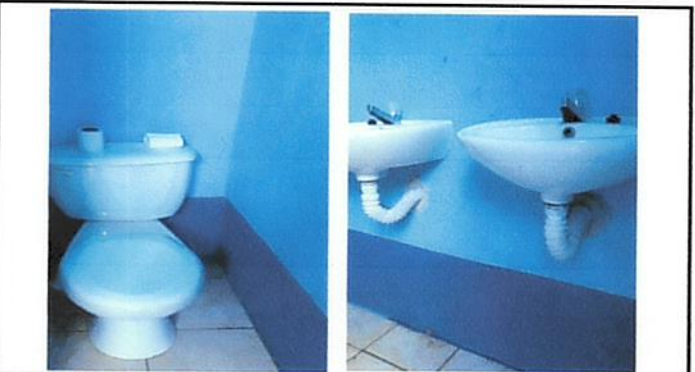
Foto 5: Mantenimiento de baños (sanitarios, lavamanos y accesorios).
